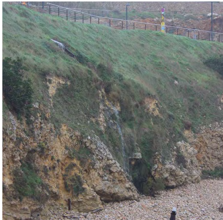
Fotografia 7. Erosió sobre els materials tous de l'escarpament, degut al drenatge dels carrers situats a la part superior.
