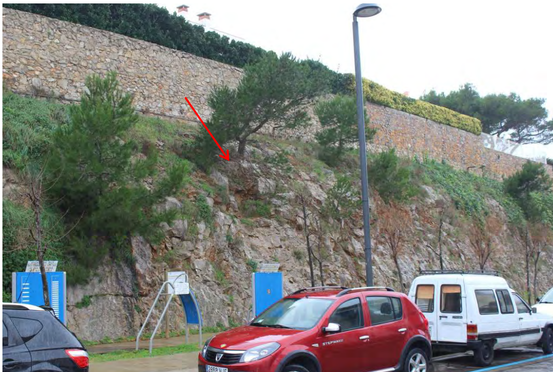
Fotografia 16. Detall del talús de la ronda del Pedró on s'hi observen arbres, un dels quals arrelat entre blocs individualitzats.
