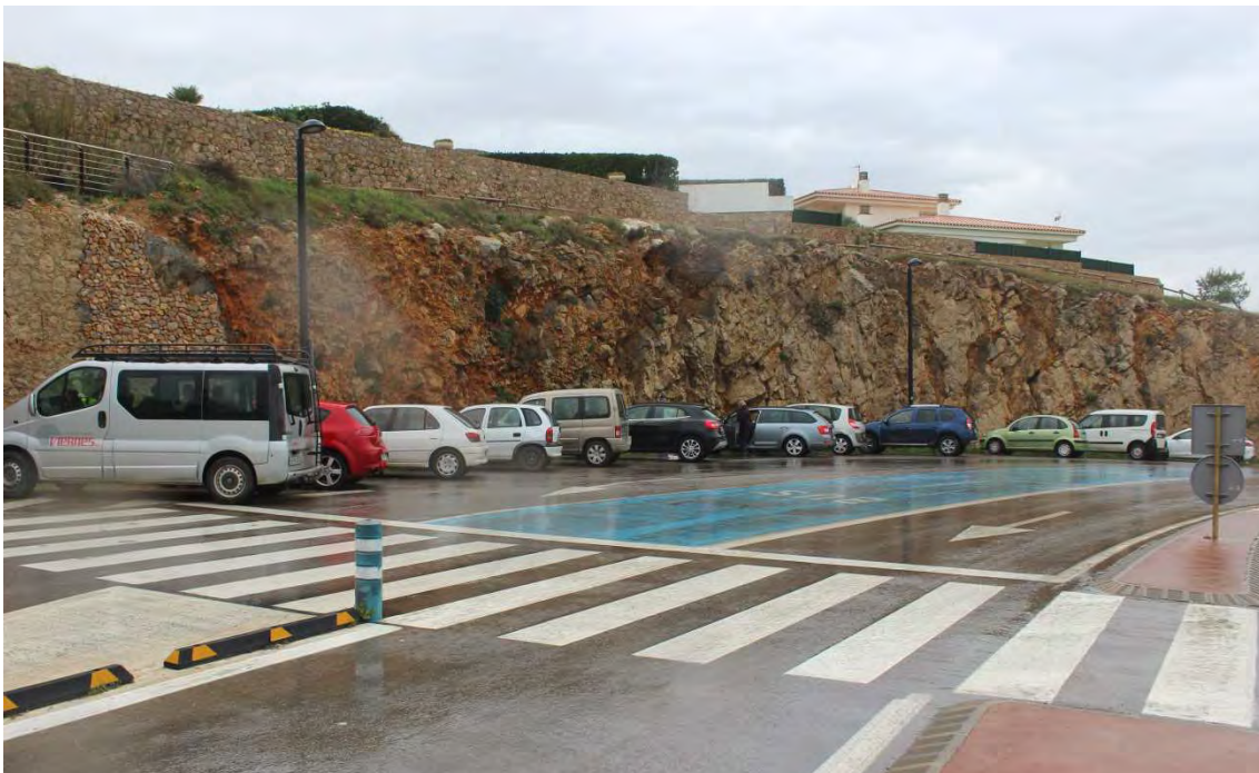
Fotografia 14. Vista del talús de la ronda del Pedró a l'estacionament de vehicles.
