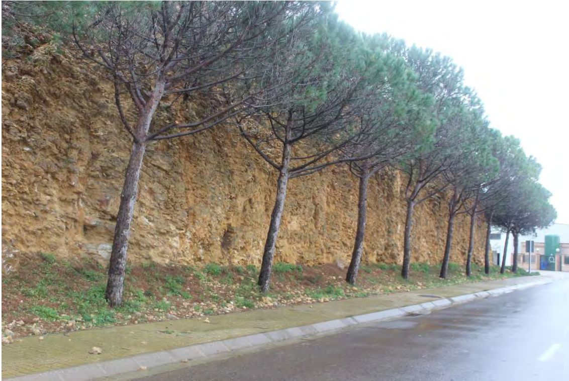
Fotografia 18. Talús verticalitzat i meteoritzat del sector del port de l'Escala al seu límit amb el sector de les Planasses
