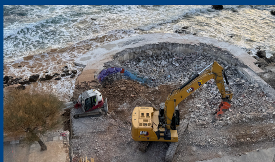
Obres al pg. Lluís Albert
